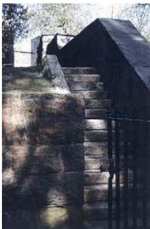
Trappor av sten, stödmur
