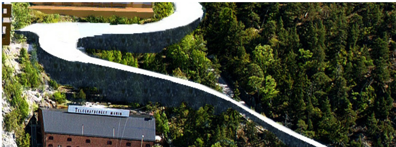
Stödmur klädd med vegetation
