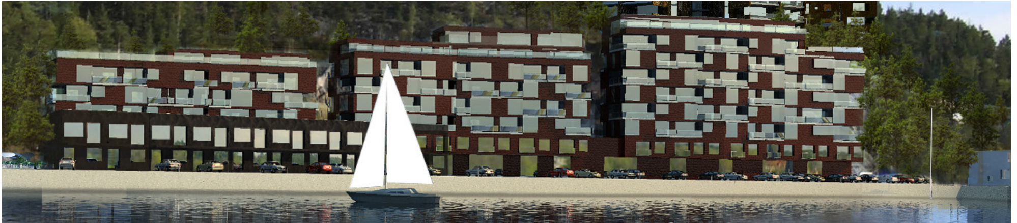
Kajhus från vattnet
